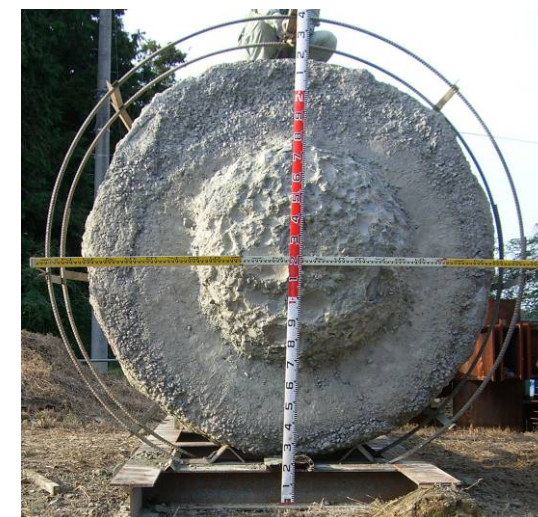
φ2100 拡底部写真 (杭先端地盤が玉石混り砂礫層にもかかわらず真円に近い拡底部)
